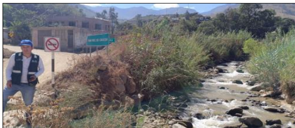
Tramo de quebrada con presencia de talud inestable y sin protección hidráulica. Se observa cercanía a infraestructura vial.
